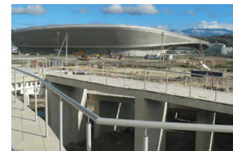
Пандусы центра керлинга в процессе строительства
