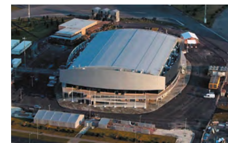
Завершенное строительство центра керлинга с пандусами
